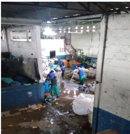
Figura 9 - Alagamento no galpão da AMARIV em um dia chuvoso
